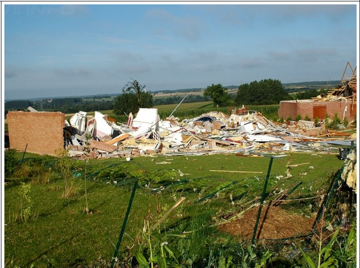
Kompletter Blowdown eines Fertighauses mit Verklinkerung (T8) Tornado 03.08.2008 - Hautmont / Frankreich (Foto: Bjoern Stumpf)
