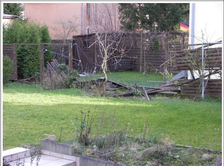
Gartenzaun aus Lamellenhölzern zerstört (T1) Downburst 18.01.2007 - (Kyrill) Pulheim / NRW (Foto: Erik Dirksen)
