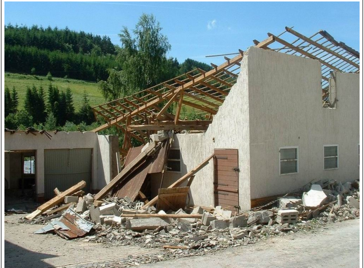
Vollständig zerstörtes und z.T. eingestürztes Nebengebäude (T6) Tornado 10.06.2003 - Acht / Rheinland-Pfalz (Foto: Matthias Habel)
