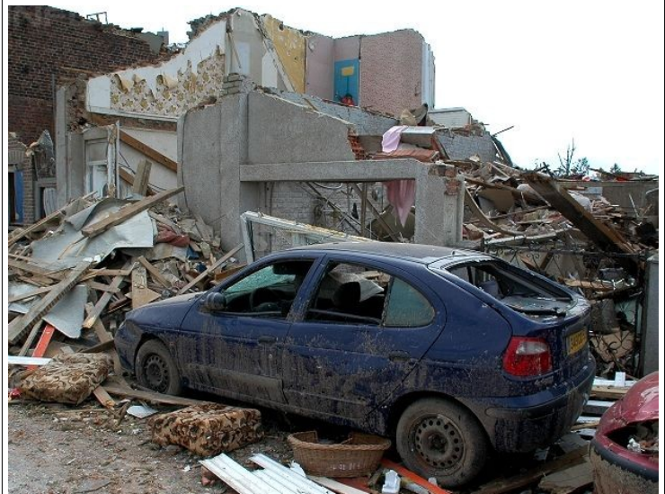
Bis auf die Ziegelgrundmauern zerstörtes massives Wohnhaus (T9) Tornado 03.08.2008 - Hautmont / Frankreich (Foto: Bjoern Stumpf)
